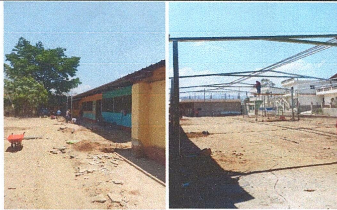
Foto 1: Colocación de losa de concreto en el patio de la escuela y su respectivo techo con lámina troquelada calibre 26, su estructura metálica de tubos galvanizados chapa 16, con su canal y bajada de agua pluvial.
